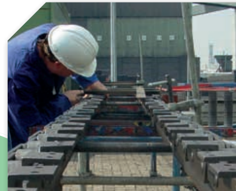
Nauwkeurige inspectie tijdens revisiewerkzaamheden
